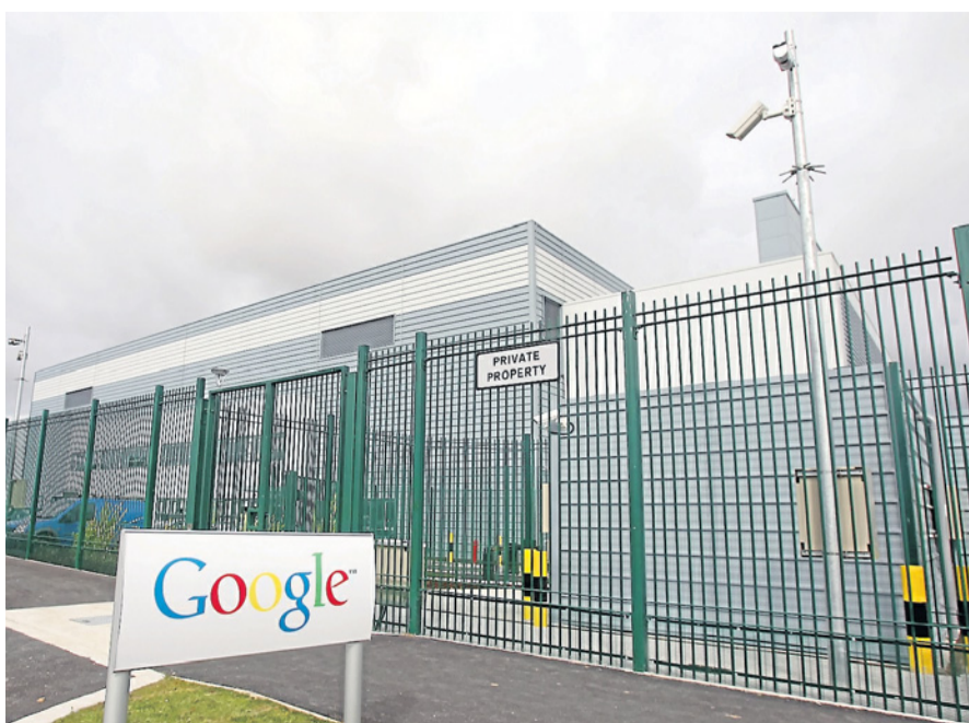
Unscheinbares Lager für den Rohstoff Daten: 75 Millionen Euro ließ sich der Internetgigant Google dieses Datenzentrum im irischen Dublin kosten.
